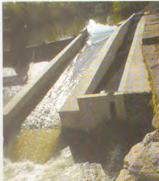
Photo n° 4 Passe à poissons
